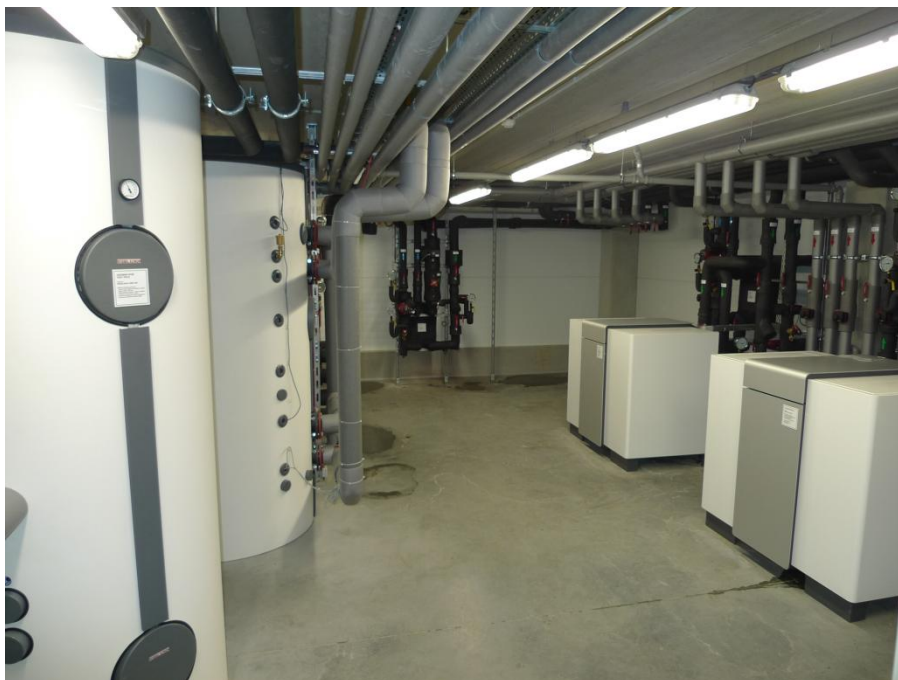
Obr. 4.2.3.7 Příklad instalace sestavy tepelných čerpadel
