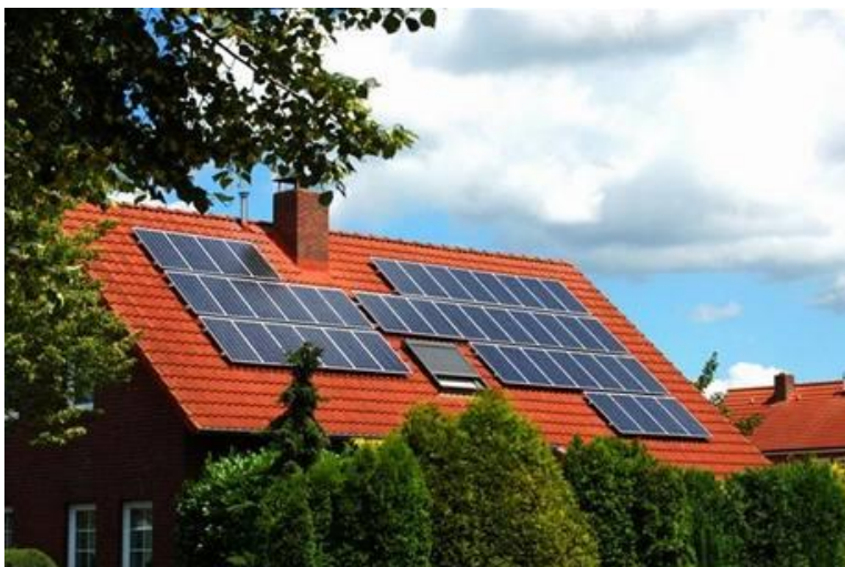
Obr. 4.2.2.6 Příklad použití fotovoltaických panelů na rodinném domě
