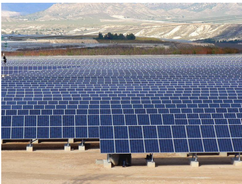
Obr. 4.2.2.7 Příklad fotovoltaické elektrárny
